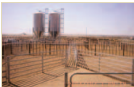
Voer word in grootmaat direk in die silos voorsien vanwaar dit elektries na die voertrollies oorgeplaas word
